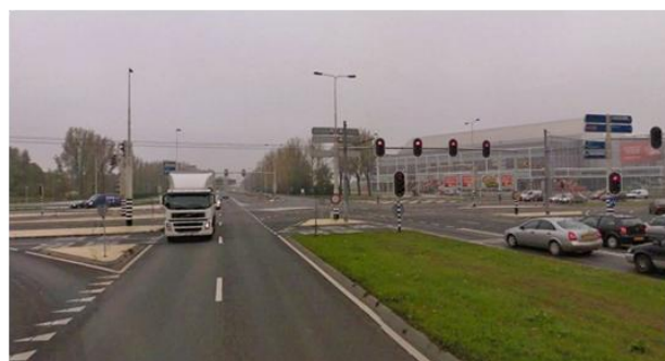
N325 Nijmeegseplein, bron: Google streetview (2011)
